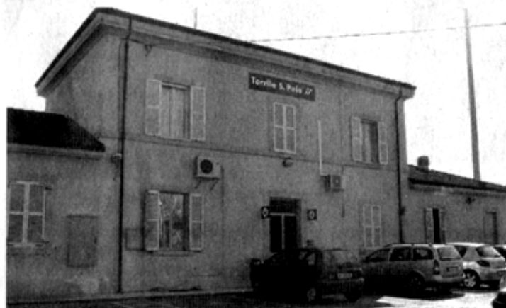
La stazione ferroviaria di San Polo di Torrile.
